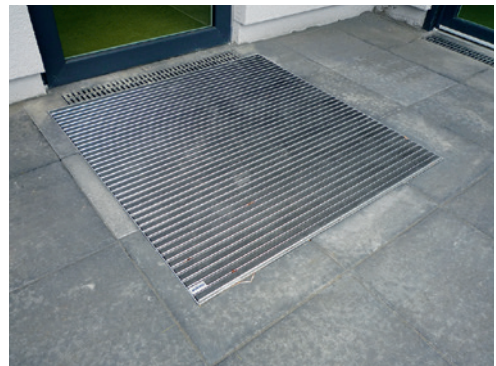
Foto 16: Bündig eingelassene Abstreifmatte in einem Kindergarteneingang
