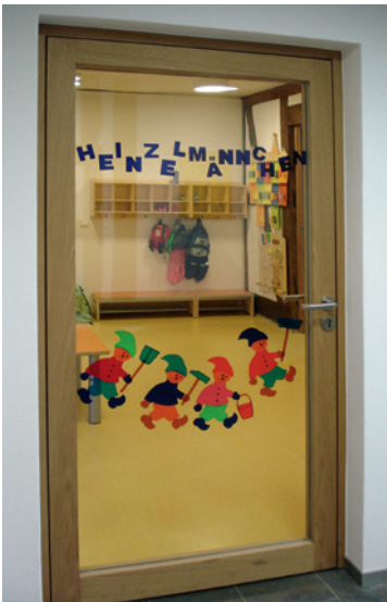
Foto 20: Kennzeichnung einer Glasscheibe an einer Tür
