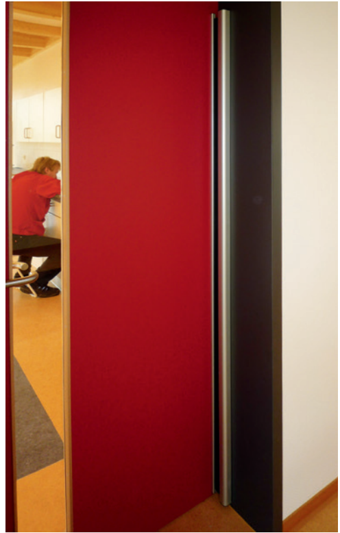
Foto 11 und Foto 12: Beidseitige Abdeckung der Nebenschließkante
