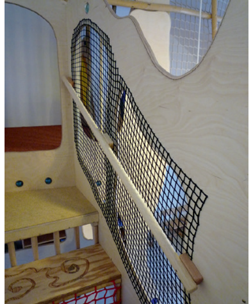
Foto 25: Absturzicherung durch feinmaschiges Netz, das nicht bekletterbar ist
