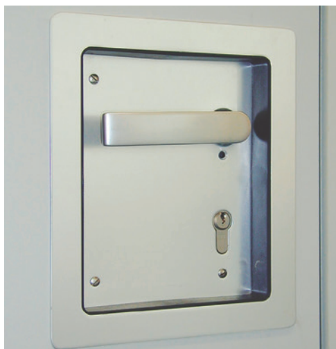
Foto 18: Türgriff (Turnhallenmuschel) in einem Mehrzweckraum einer Kindertagesstätte
