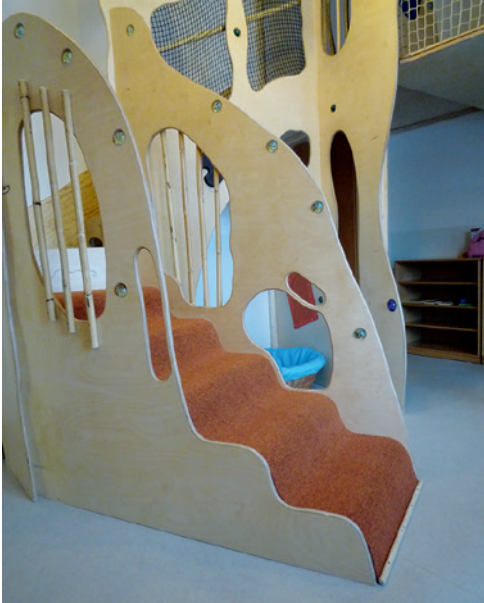
Foto 23: Wellentreppe und Brüstungselement als Aufstiegshilfe
