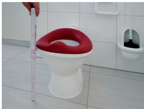
Foto 31: Toilettenbecken in einer Kinderkrippe
