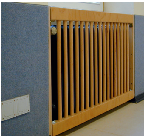
Foto 22: Abdeckung eines Stahlgliederheizkörpers in einem Mehrzweckraum
