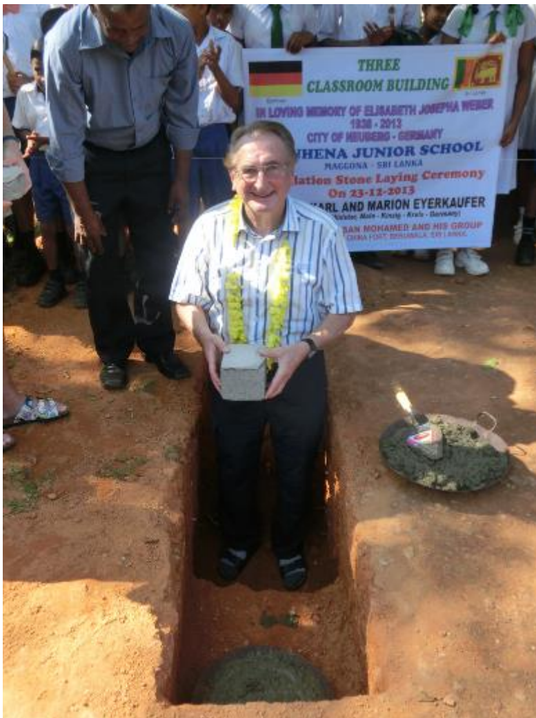
Besonderer Festakt: Landrat a.D. Karl Eyerkaufner legte den Grundstein für das neue Schulgebäude in Beruwala. Die Mumhena Junior School erhält ein neues Gebäude mit drei Klassen- und Nebenräumen.
