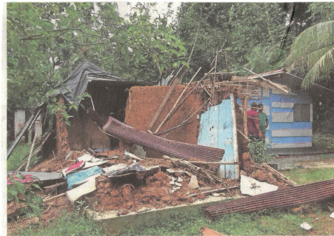
Eingestürzte Hütte, die durch einen Neubau (rechts) ersetzt wurde.
